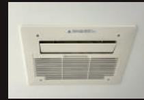
浴室暖房乾燥機
