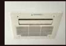
浴室暖房乾燥機
